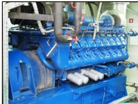
Fotografija 7: Motor, ki deluje na bioplin. (Fotografiral: Kristjan Panjan, 4. 12. 2010.)
