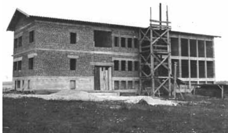
Potek gradnje šole
