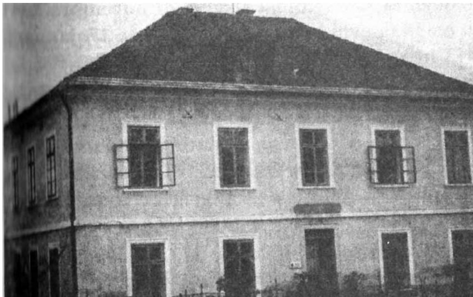
Šolska zgradba v Dragatušu 1887–1944
