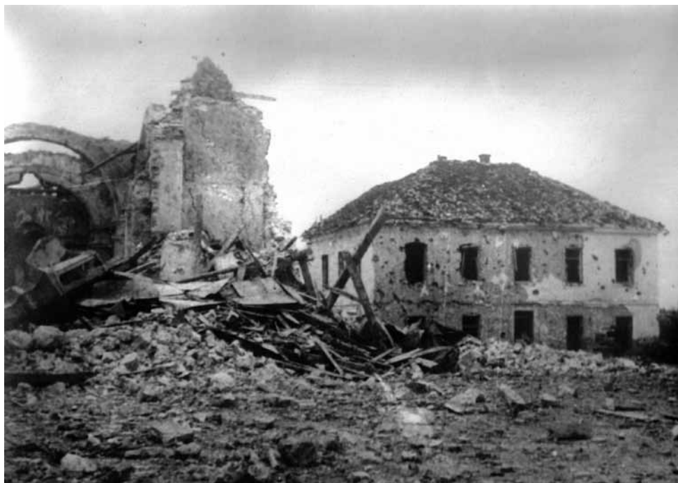
Porušena šolska zgradba leta 1944
